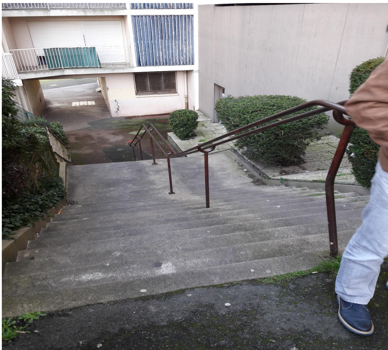
Escalier vue depuis le 11 Passage Savary (intérieur de l'ilot)
