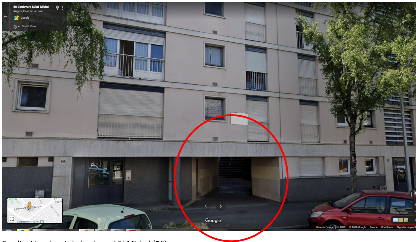
Escalier Vue depuis le boulevard St Michel (56)
