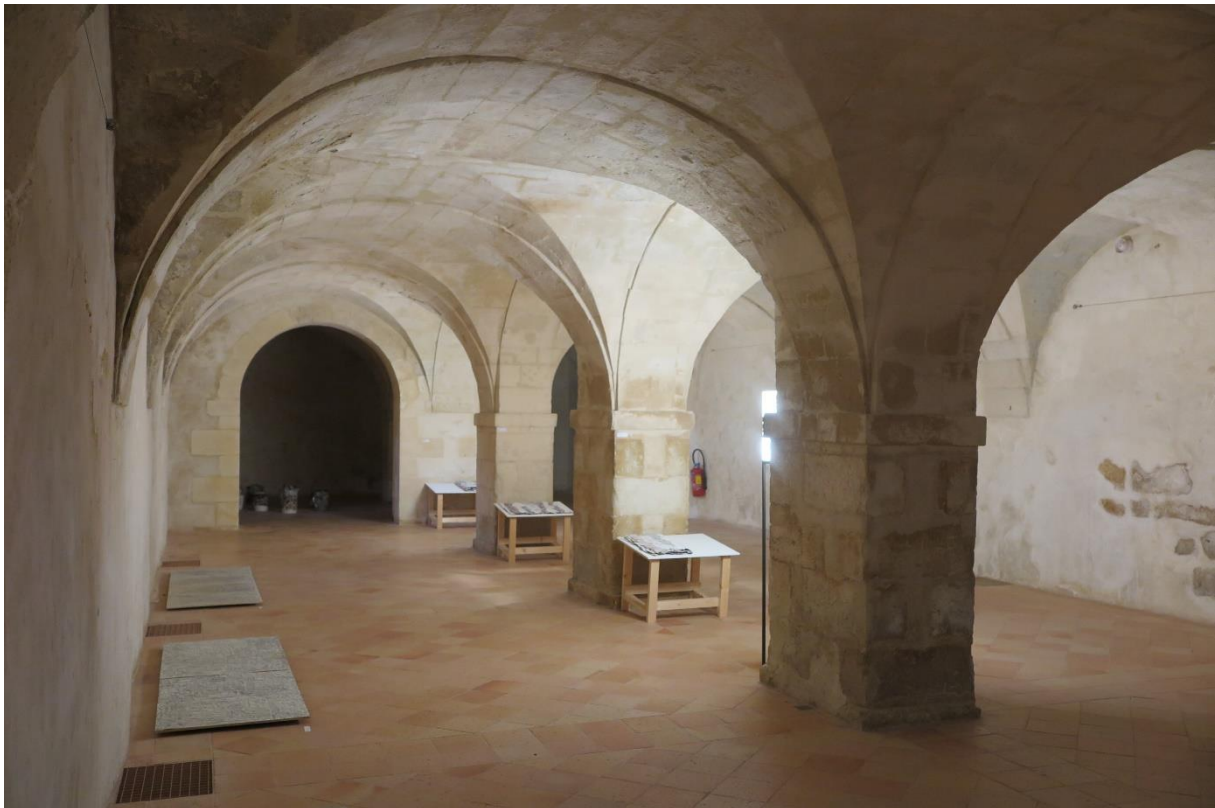
Salle des caves de l'abbaye, sous-sol d'environ 200m 2
