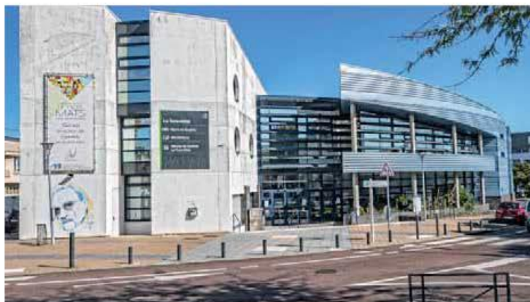
L'extension, réalisée par l'architecte Sophie Saigneurin, utilisera des matériaux biosourcés comme le béton de chanvre pour les murs de façade et la chaux pour les enduits.
